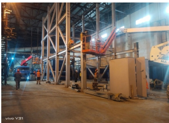
Модернизация линии МДФ-2 ООО «ШКДП»
