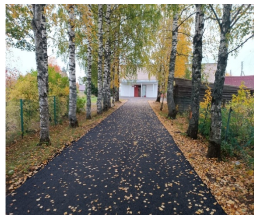
Ремонт дороги ул. Центральная в д. Княже
