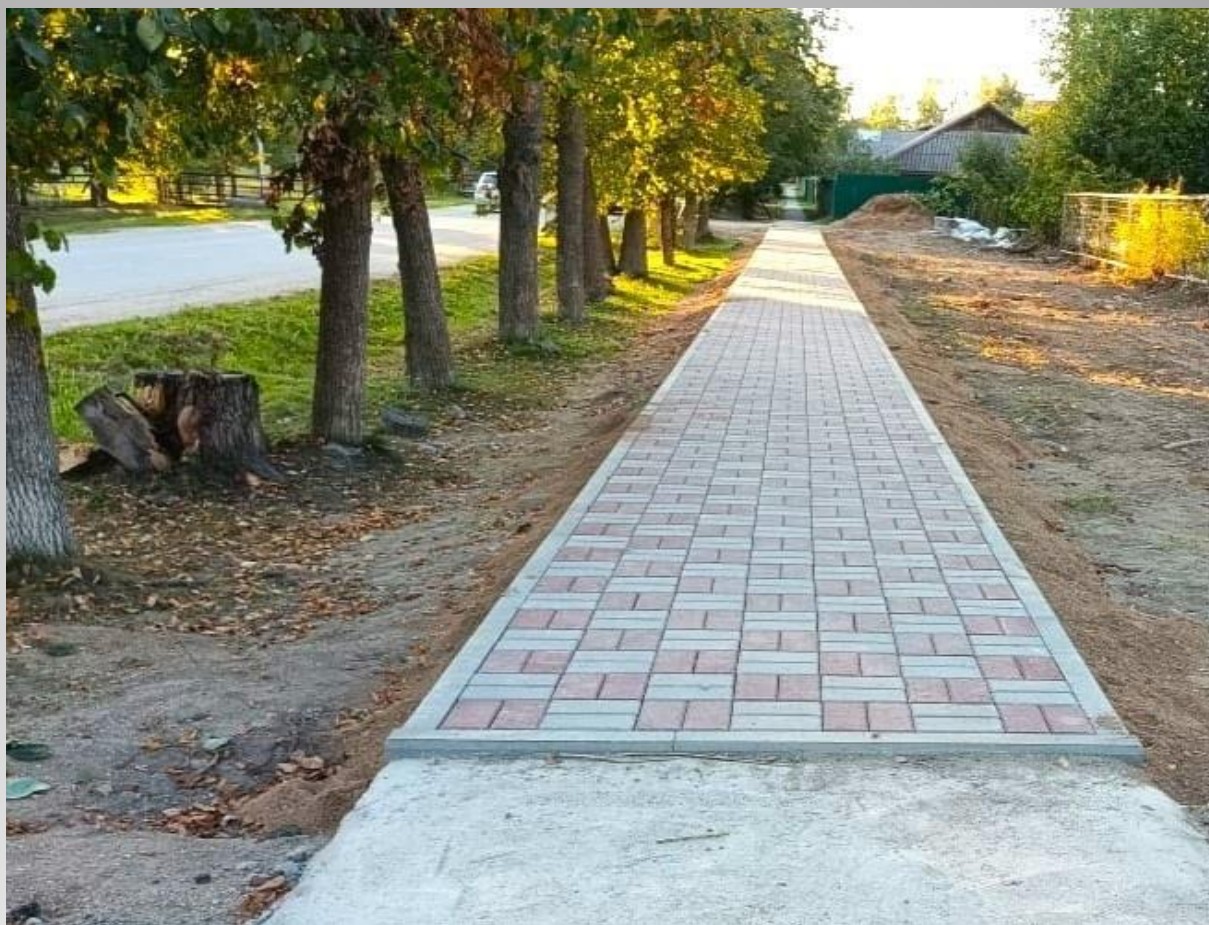
Устройство тротуара по ул. Шлюзовая в п.Шексна
