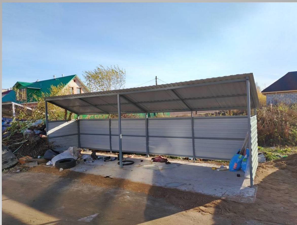
Устройство площадки ТКО п. Шексна, ул. Молодежная д. 2,4
