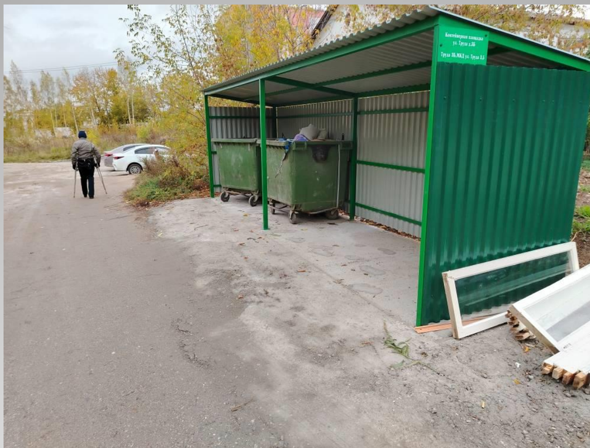
Устройство площадки ТКО п. Шексна, ул. Труда д. 3,5
