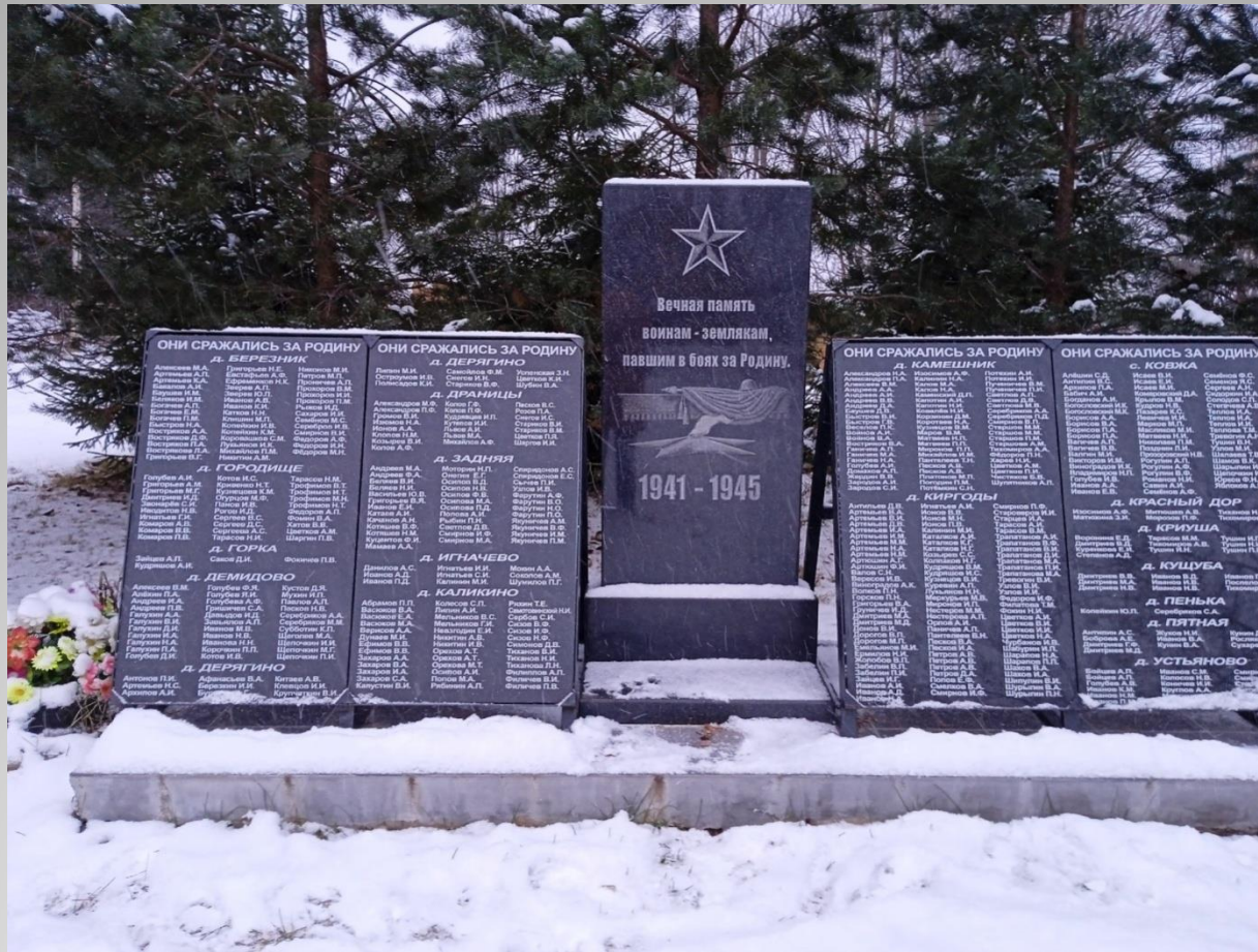
Ремонт мемориала воинской славы в д. Камешник сп Ершовское
